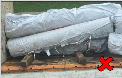
*Das vordere Rohr mit größerem Durchmesser kann nicht sauber angehoben werden, da es schräg auf den Kanthölzern liegt und durch das darüber liegende Rohrpaket blockiert wird. Zudem fehlen Holzkeile, die das Herabrollen von der Ladefläche verhindern. Das obere Paket kann ebenfalls nicht sauber angehoben werden, es fehlen Kanthölzer zur Zwischenlagerung. Zudem besteht die Gefahr des Herabrutschens nach Wegnahme des unteren Rohres.*
