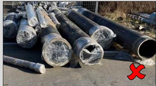
*An den Rohren wurden nur die Rohrenden verpackt, die Verpackung muss jedoch das gesamte Rohr umschließen. Dünnere Rohre liegen nicht gebündelt vor und sind daher schlecht händelbar. Zudem ist die verwendete Folie nicht reißfest und zum Teil bereits aufgerissen.*
